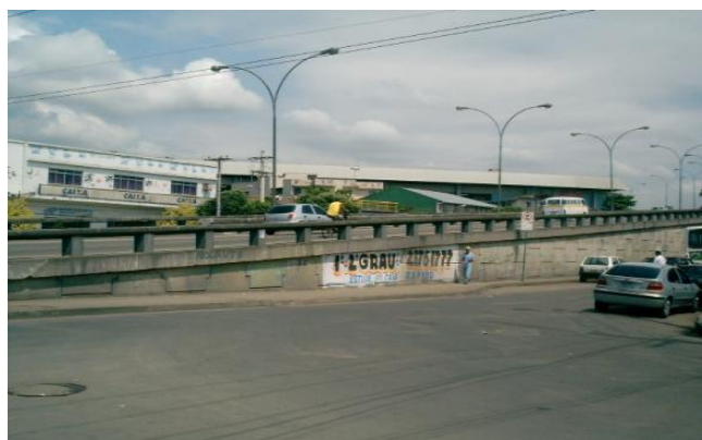
Foto 6: Viaduto da Pavuna na subárea 4 (2005).
