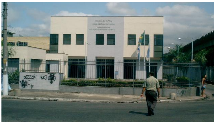
Foto 3: Fórum Regional da Pavuna na subárea 5 (2005).
