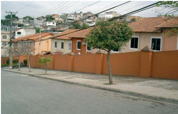
Foto 7: Condomínio construído em antigo terreno próximo à estação do metrô (2005).
